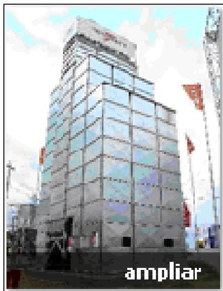
A linha de secadores ADS com torre de colunas apresenta características inovadoras como secagem mais homogênea (menos de 1% de variação de umidade), fácil operação, secagem de produtos com alto teor de impurezas (até 4%) e menor retenção destas impurezas na torre de secagem, o que evita interrupções na operação de secagem.
