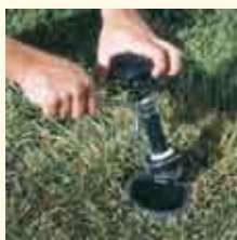
1 Retire o interior do aspersor que está no terreno.
