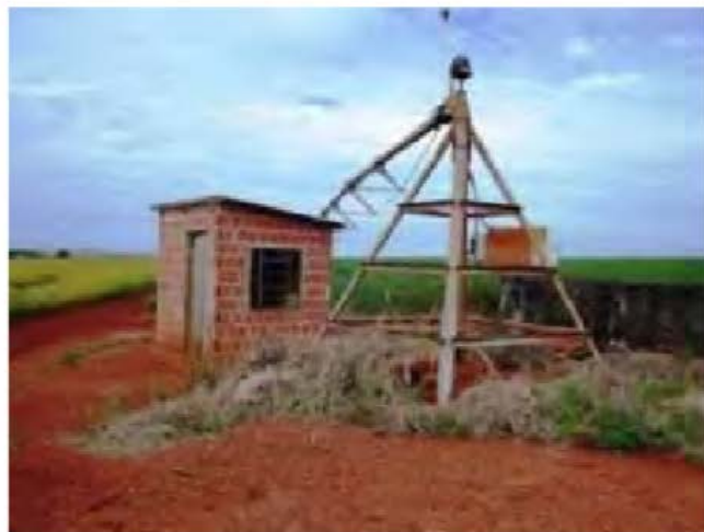
Foto - Guarita construída no pé do pivô para abrigar vigias
