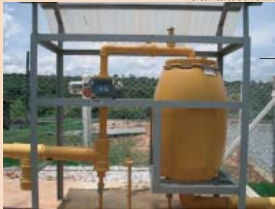
O biodigestor (à dir.) elimina parte do efeito estufa do chorume suíno. Para certificação, o medidor (à esq) é controlado permanentemente
