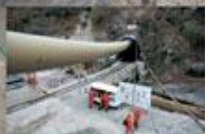
A saída do túnel do lado ocidental da cordilheira
