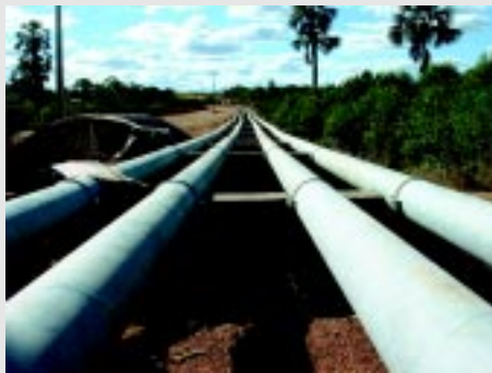
A tubulação adutora permite que a água do rio chegue ao pivô
