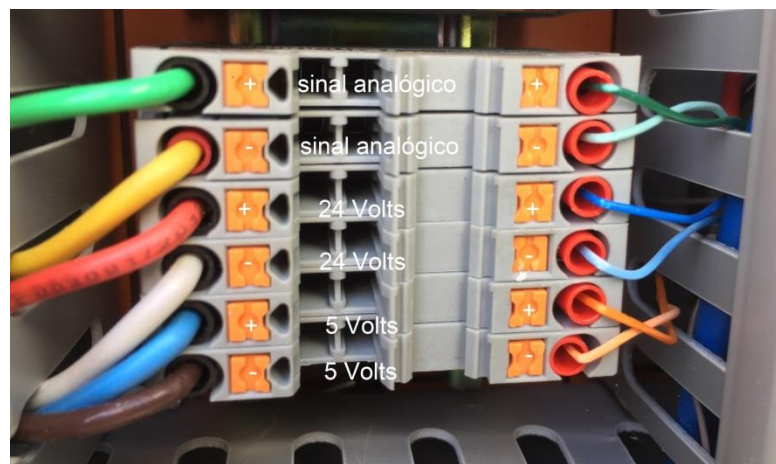
Figura 18 - Conexão Elétrica entre Pannel e Sensor
