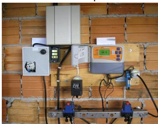
Figura 235: Detalhes da instalação de um controlador de irrigação.
