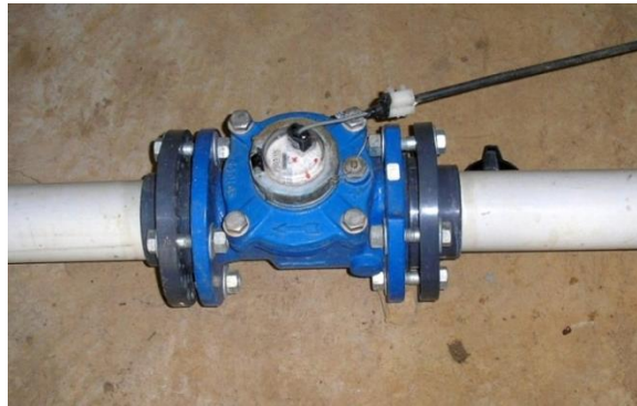
Figura 124: Detalhe de uma válvula volumétrica instalada na tubulação de um cabeçal de controle.
