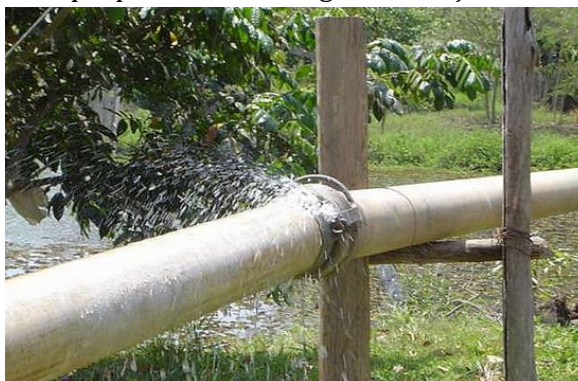
Figura 245: Vazamento em tubos metálicos de irrigação.
