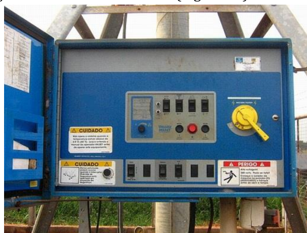
Figura 81: Modelo de caixa de controle instalada na torre central de um pivô.
