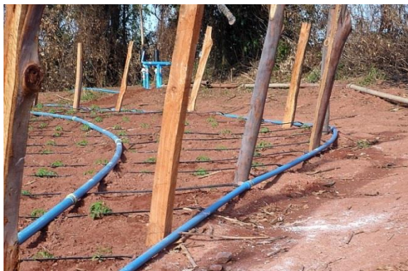
Figura 244: Linhas de derivação de PVC dispostas encurvadas em um sistema de gotejamento.
