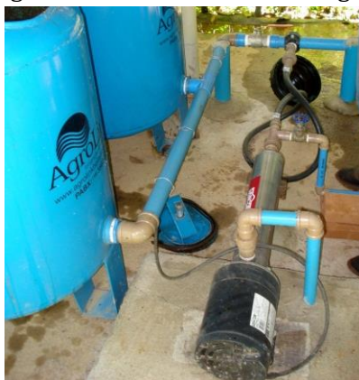
Figura 131: Sistema de fertirrigação por bomba centrífuga com corpo de inox.
