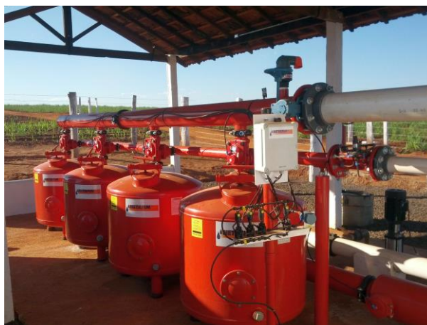
Figura 181: Instalações de um cabeçal de controle para irrigação por gotejamento subsuperficial em cana de açúcar.
