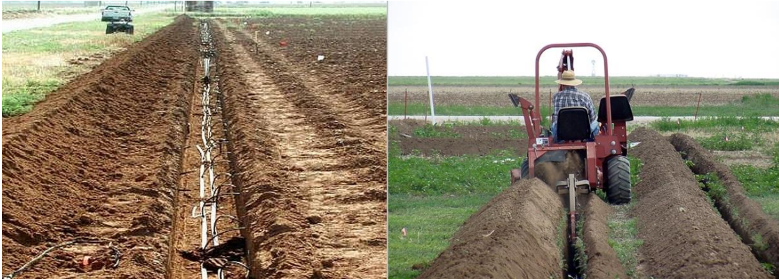
Figura 184: Detalhes da instalação das linhas secundárias e das laterais (KIZER, 2011).
