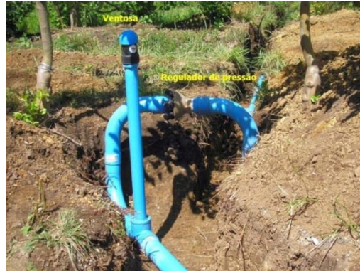
Figura 133: Detalhe da instalação de uma ventosa em tubulações de irrigação localizada (Fonte: ANTUNES, 2006).
