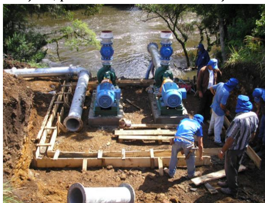
Figura 240: Exemplo de um canteiro de obras para montagem do sistema de bombeamento (ANTUNES, 2006).
