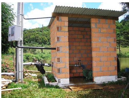
Figura 55: Casa de motobomba movida à energia elétrica em propriedade rural.
